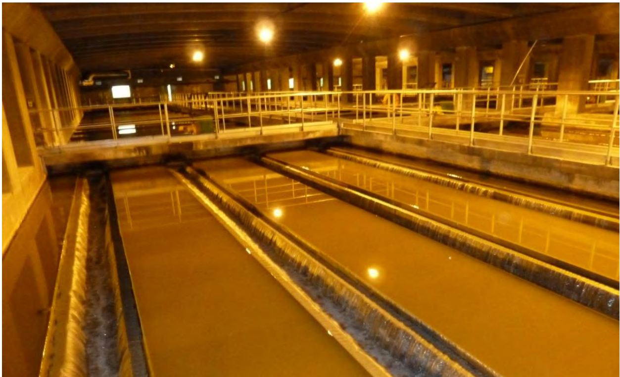
Abbildung 4.7: Absetzbecken 40 mal 60 Meter Quelle: Thiemann 2013
