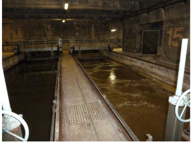
Abbildung 4.5: Sand- und Fettabscheider Quelle: Thiemann 2013
