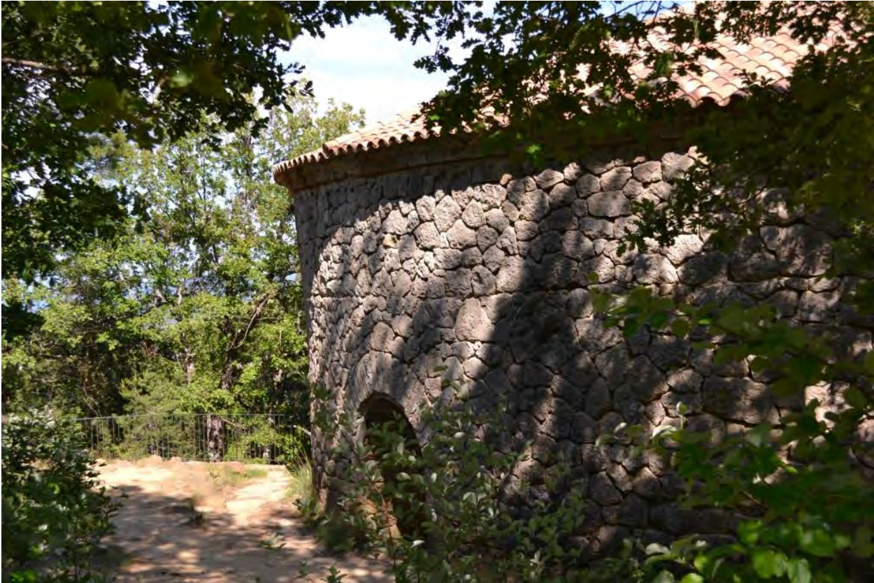
Abbildung 5.13: Obere Türe des Eiskellers auf Höhe der Becken zur Einlagerung des Eises
