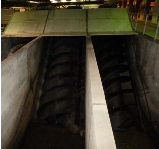
Abbildung 4.6: Archimedische Schnecke. Quelle: Thiemann 2013
